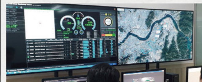
综合管制室Big Data管理
